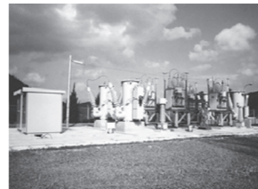
配電自動化システム
