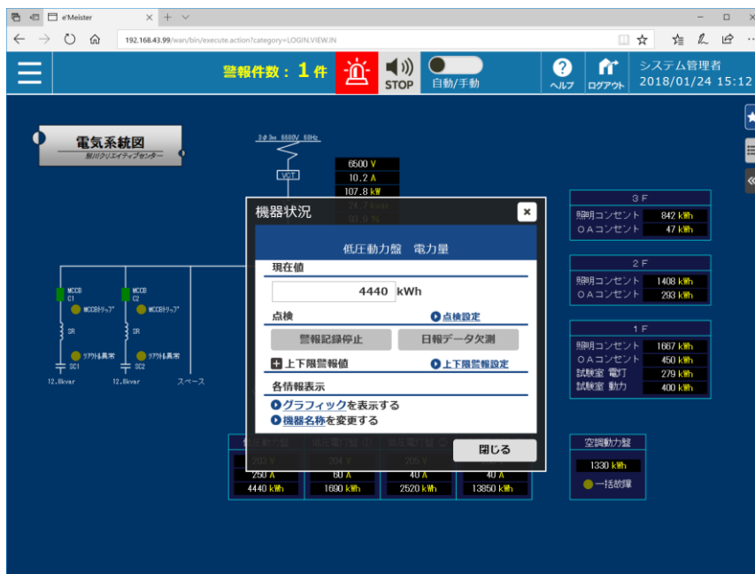
【機器状況画面（計測、計量機器）】
